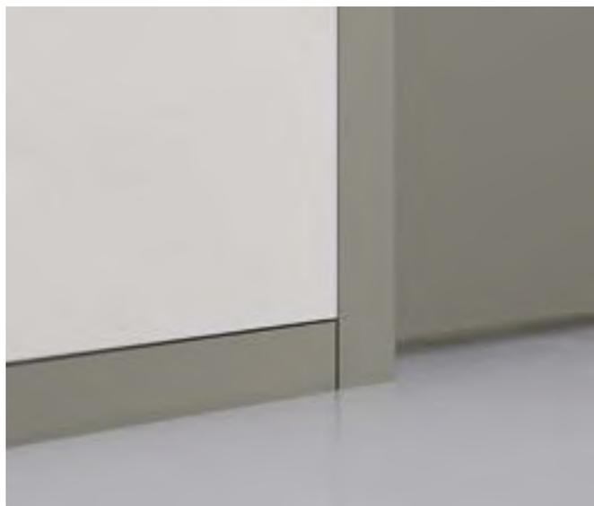
Il battiscopa montato a raso muro rappresenta un'idea innovativa per arredare gli spazi della casa in modo elegante, moderno e minimalista. A differenza dei tradizionali battiscopa, la versione montata con superficie a filo scorre a livello del muro senza sporgere.
