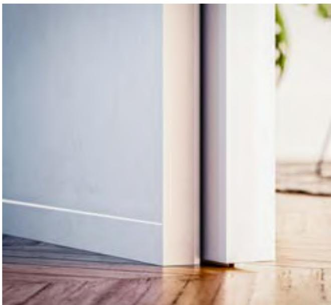
Questa soluzione si realizza predisponendo l'incavo per il battiscopa e collocando degli appositi profili in alluminio (vedi immagine sotto) in fase di costruzione della parete, prima di eseguire l'intonacatura (o il fissaggio delle lastre di cartongesso) e la posa del pavimento.
