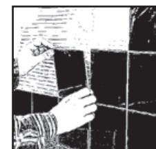
Le piastrelle da muro possono essere incollate sul Climapron Plus utilizzando un adesivo in dispersione per piastrelle. Dopo una settimana di asciugatura si possono chiudere le giunture fra le piastrelle.
